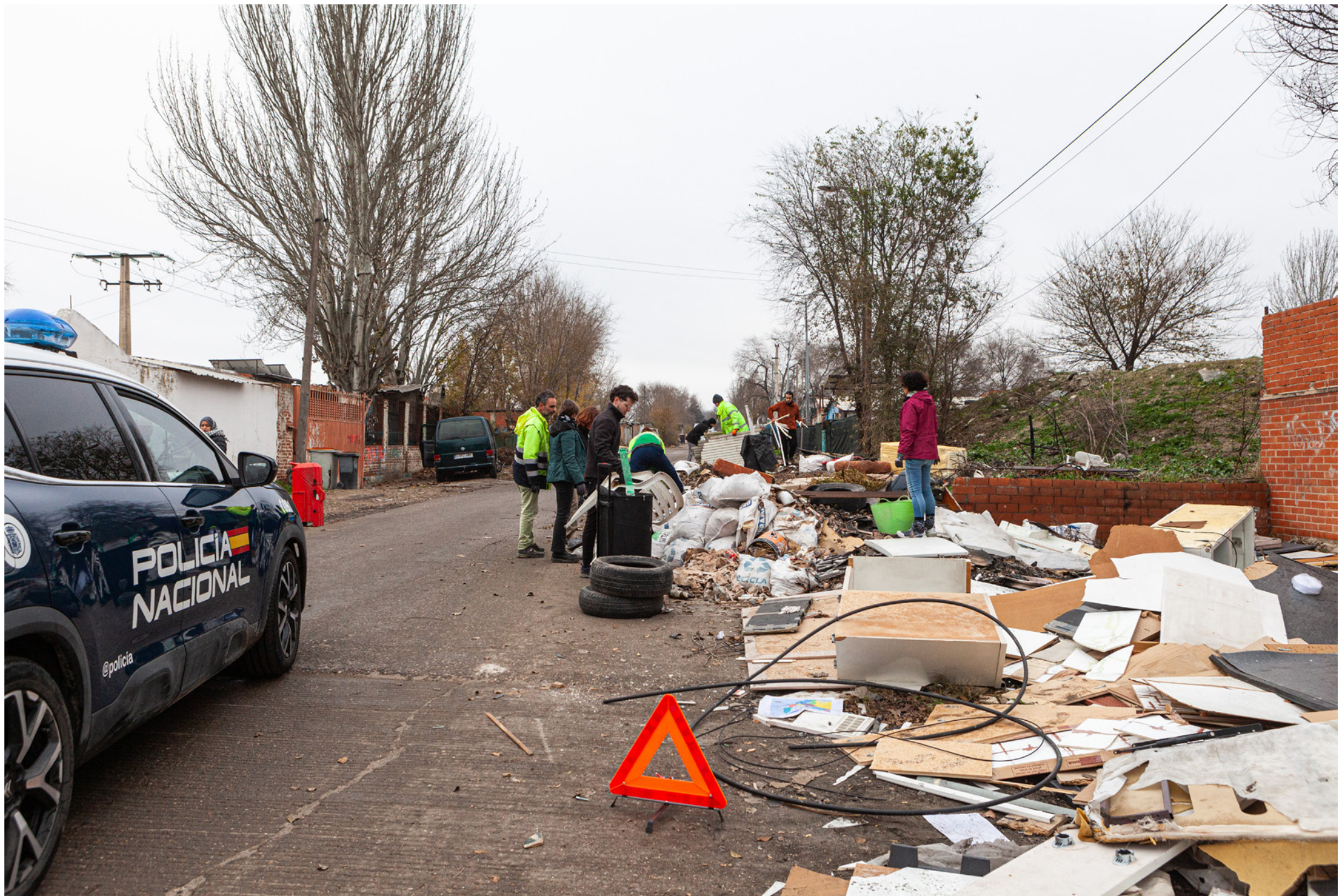
Acción de recogida de escombros y limpieza junto con la comunidad del sector 6 para despejar la calzada y permitir el paso a los autobuses escolares que recogen a los niños de la Cañada cada mañana
