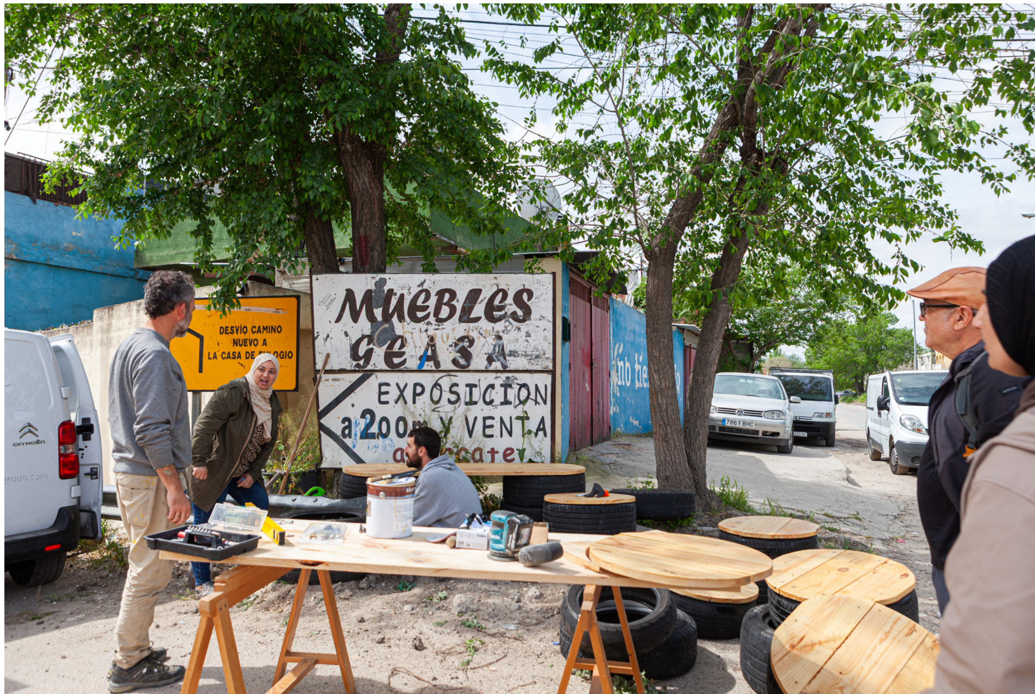
Equipo Estéticas energéticas en la construcción de la parada de autobús
